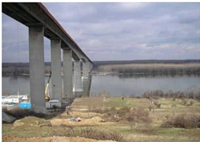
Сл. 4. Калакача – мост у току радова 2007. године Fig. 4. The Kalakača – bridge during excavation 2007
