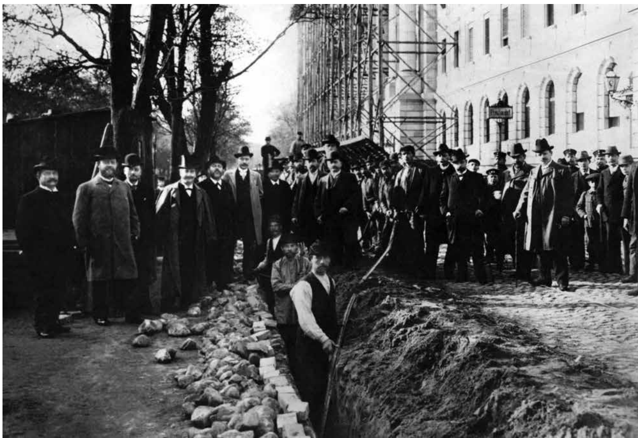
Постављање Пупинових каблова у Потсдаму код Берлина Installation of Pupin coils at Potsdam near Berlin
